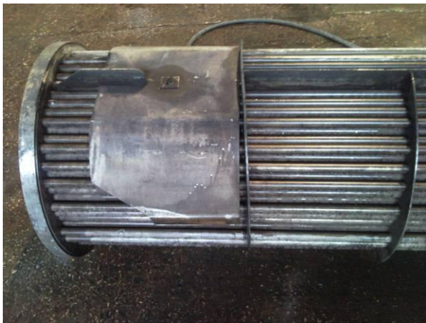
Мойка теплообменника моющим СНПЗ.
